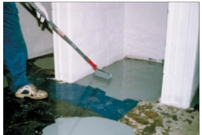
Nach Härtung über Nacht erfolgt der Auftrag einer selbstverlaufenden Belages nach der Rezeptur.
