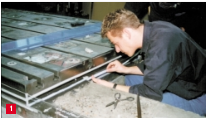
Die Stahlplatte ist mit Stellschrauben justiert und wird mit Plexiglas eingeschalt. Zum Verkleben wird das R&G Vakuum-Dichtband eingesetzt. Das durchsichtige Plexiglas erlaubt eine optimale Kontrolle des Vergusses.
