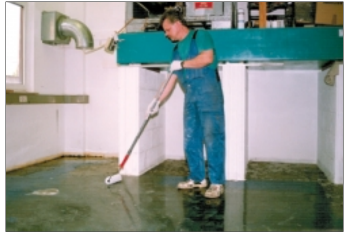
Aus Epoxydharz, Isopropanol und Xylol wird nach Rezeptur eine sehr dünnflüssige Imprägnierung hergestellt und mittels Walze aufgetragen.
