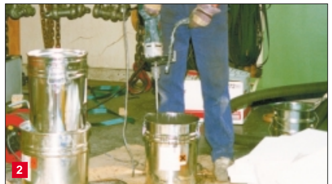
Das Harz wird in 30 kg-Chargen mit einem handgeführten Rührwerk angemischt. Dabei ist der Wandung und dem Boden des Mischgefäßes größte Aufmerksamkeit zu schenken.
